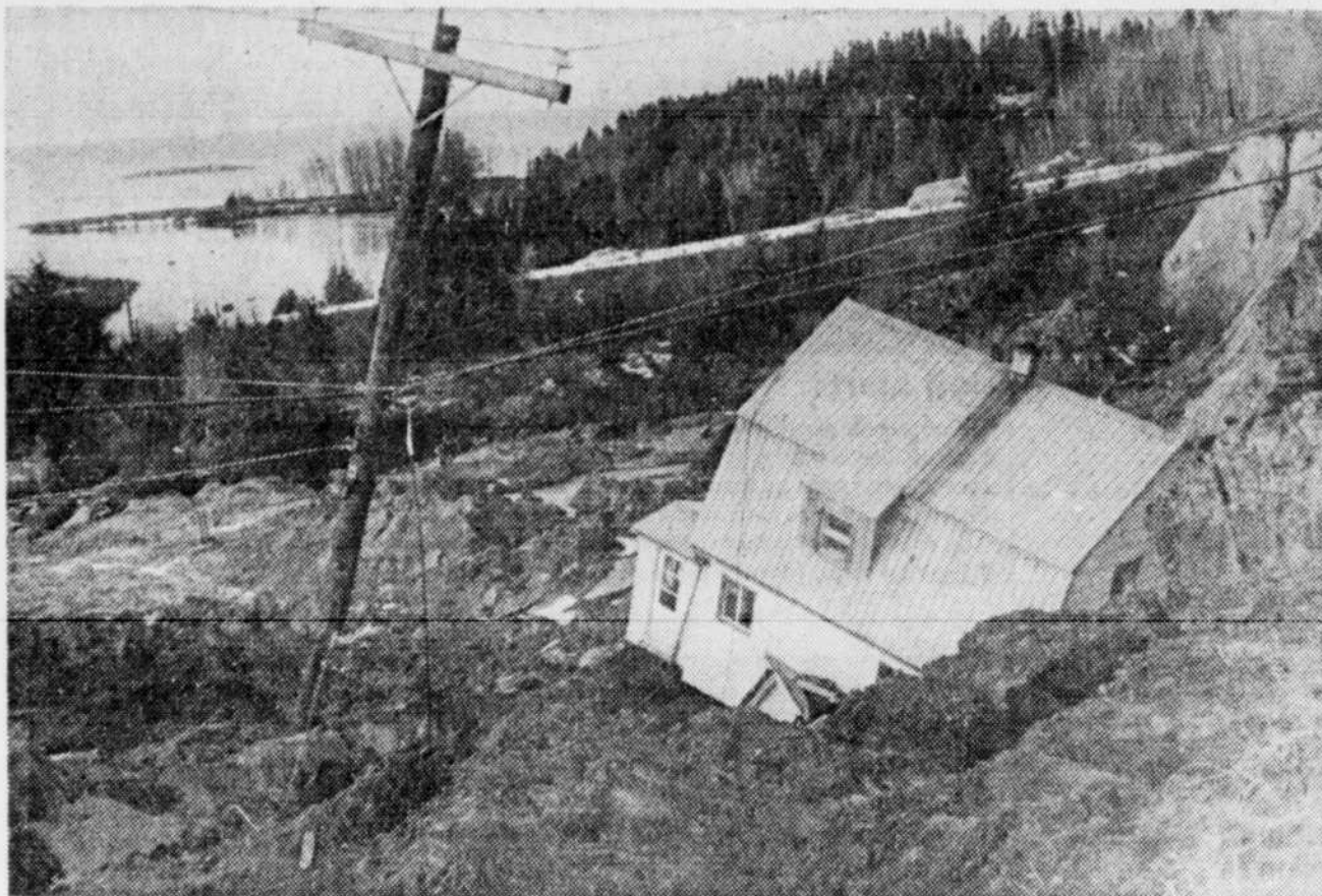
Une maison a glissé dans le trou qui s'est agrandi considérablement.
