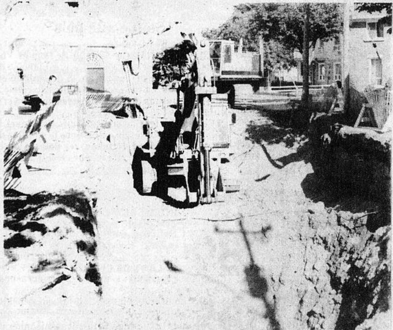
Le village de Beaumont est présentement sens dessus dessous, à cause d'importants travaux de construction d'un aqueduc et d'égoûts qui sont en cours.
