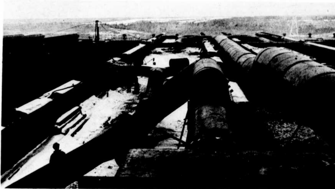
Les principales canalisations d'une demi-salle de cuves.
