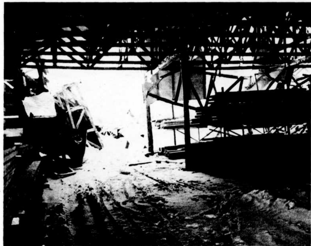
IL A NEIGE A L'INTERIEUR — On sait bien, lorsqu'il manque une bonne section de toiture, écrasée par la neige, il faut qu'il y ait de la neige à l'intérieur, et surtout s'il a un peu neigé de nouveau depuis le
