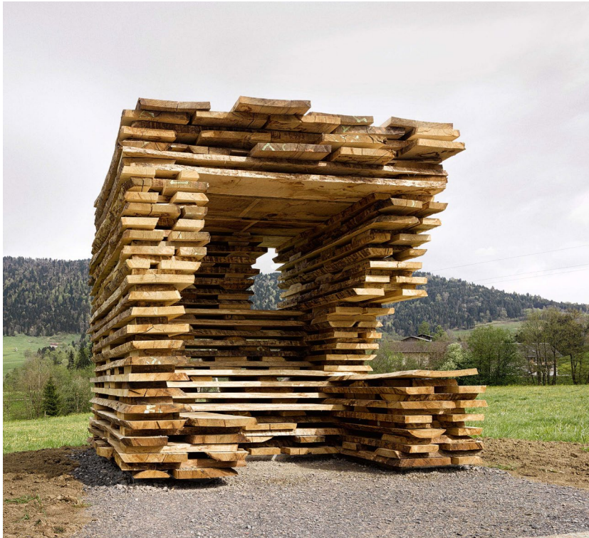
Fig. 1 Station de bus Unterkraubach Nord, projet BUS: STOP Krumbach, Vorarlberg, conçue par Antón García-Abril et Débora Mesa du studio Ensemble
