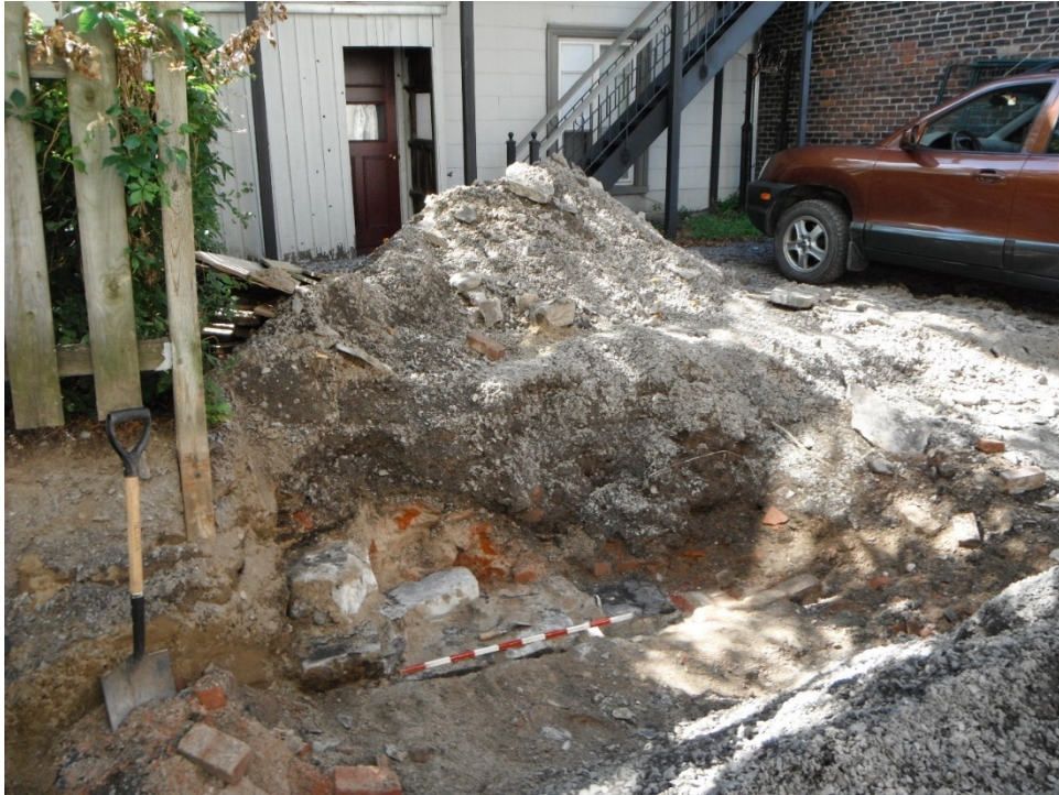
Photo 9 Vestiges de dépendances en brique dans l'arrière-cour du 9, rue Sainte-Famille, vue vers le nord-ouest (VDQ1607-NUM2-101)
