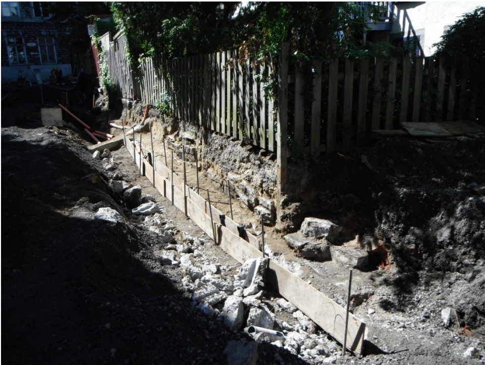
Photo 10 Mur de fondation est d'une dépendance en brique, vue vers le sud-ouest (VDQ1607-NUM2-117)
