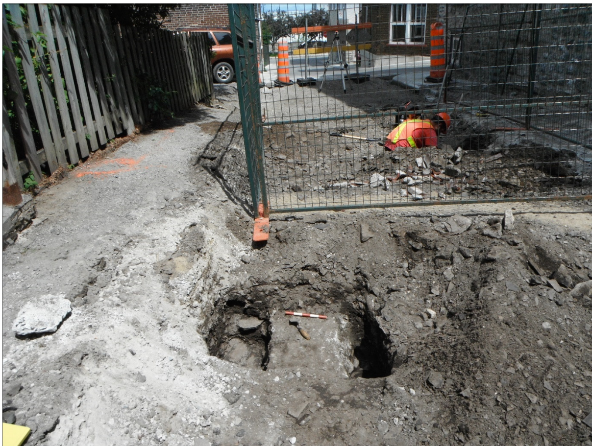
Photo 5 Fin de fouille du sondage VDQ1607-1D, vue vers le nord (VDQ1607-NUM2-18)
