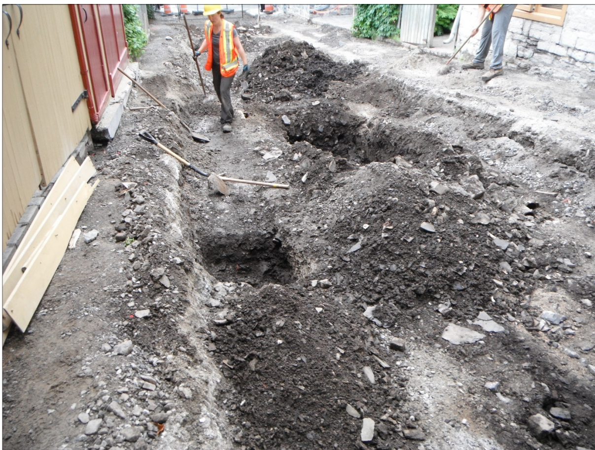
Photo 7 Sous-opération CeEt-353-3C en cours de fouille, vue vers le nord (CeEt-353-16-NUM1-32)
