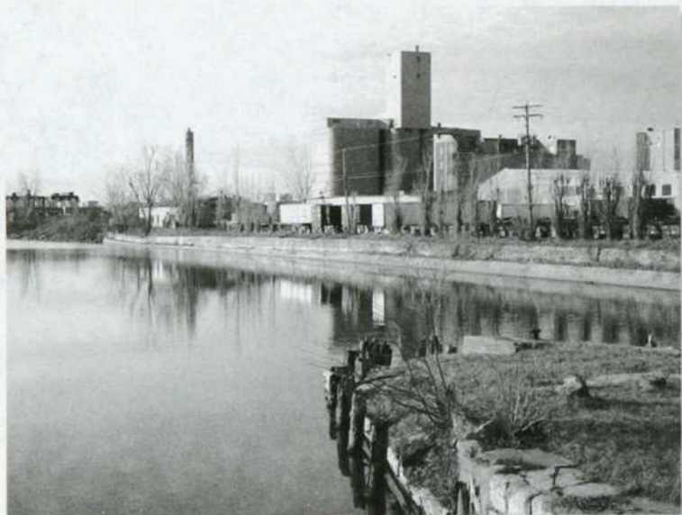
Le Canal Lachine vu de l'Écluse Saint-Gabriel va subir un vaste programme de réaménagement afin de le rendre à nouveau navigable.
