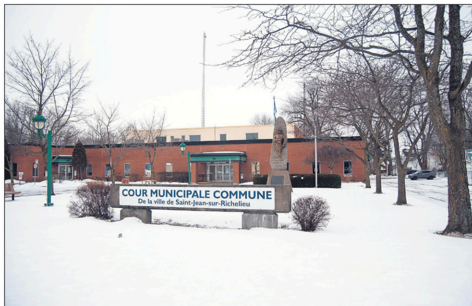
Les travaux doivent porter principalement sur la reconstruction de la toiture et la réfection de la maçonnerie.
