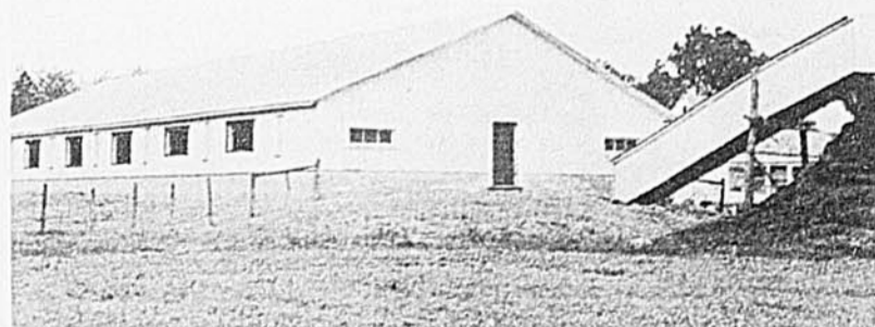
Porcherie moderne de 39 par 95 construite l'an dernier. A noter le nettoyeur automatique. "Une des bonnes porcheries de la province", de dire M. Laferrière. La valeur des stocks d'élevage justifiait une telle mise de fond. Ils en sont dignes.
