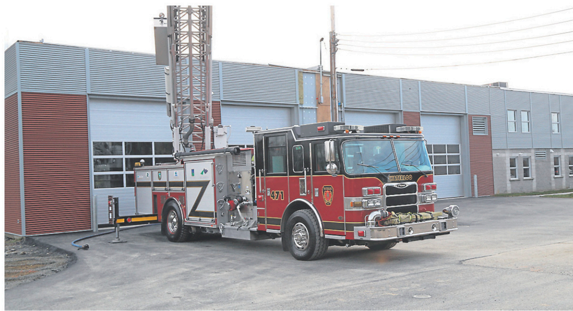
Particulièrement attendue, la nouvelle caserne de Waterloo a été inaugurée jeudi après-midi. — PHOTOS JANICK MAROIS
