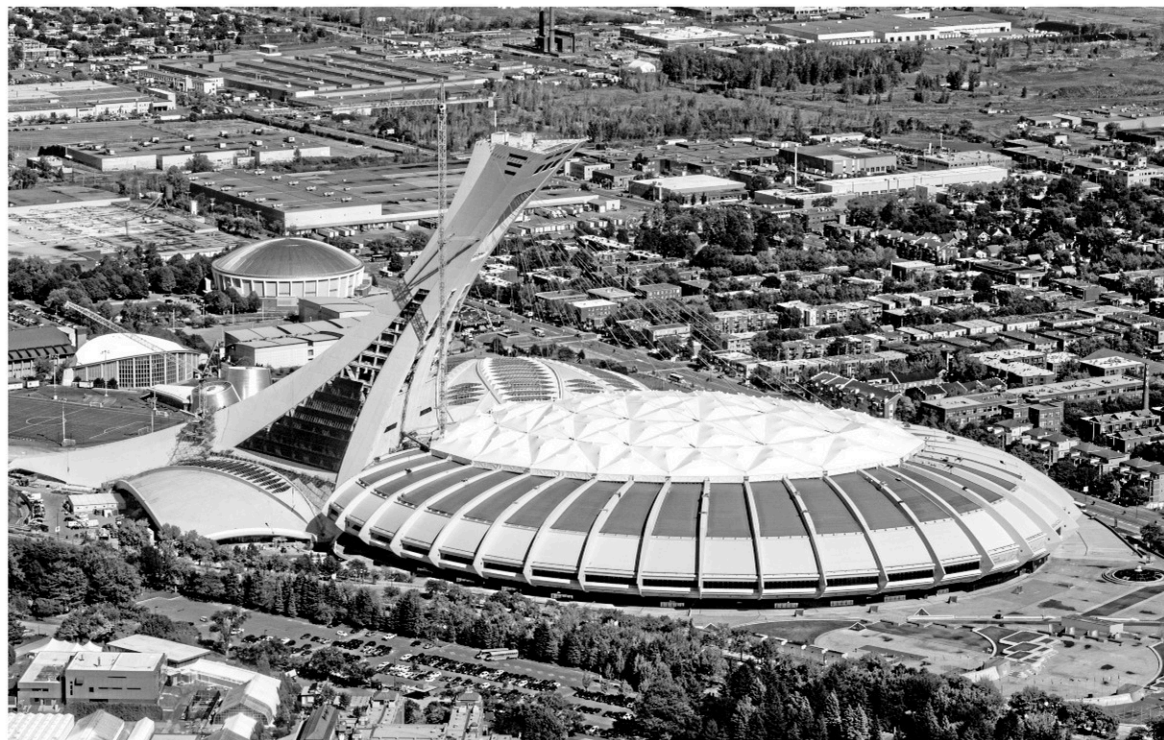
Huit mille déchirures ont dû être réparées depuis 2007 sur le toit du stade olympique de Montréal, photographié cet automne. — PHOTO ARCHIVES LA PRESSE
