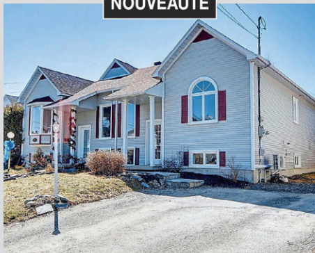
Sherbrooke , jumelé clé en main, 2CAC + 2 possible, patio sur 2 paliers avec une section couverte | 299 000 $
