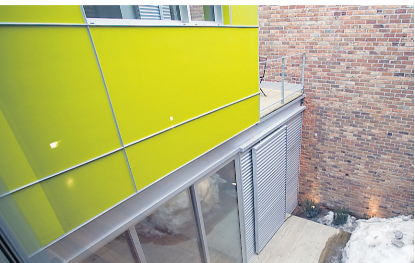
La cour arrière de ce cottage est complètement à l'abri des regards indiscrets. Le parement en fibrociment vert lime a comme fonction de réfléchir la lumière vers le sol, en plus d'apporter une touche « funky » au bâtiment.
