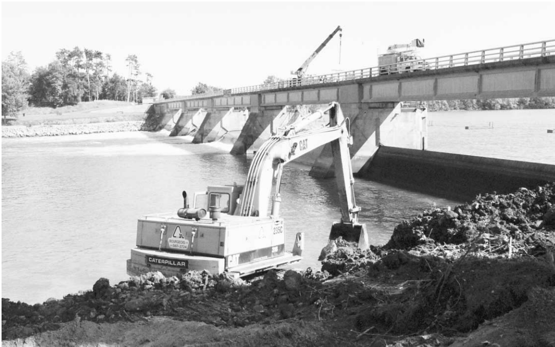
Travaux de construction d'une passe migratoire au barrage de Saint-Ours, sur le Richelieu, il y a un an et demi.
