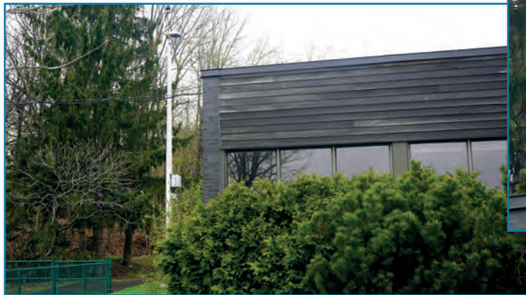
Détecteur de foudre au parc naturel Terra-Cotta, Ville de Pointe-Claire
