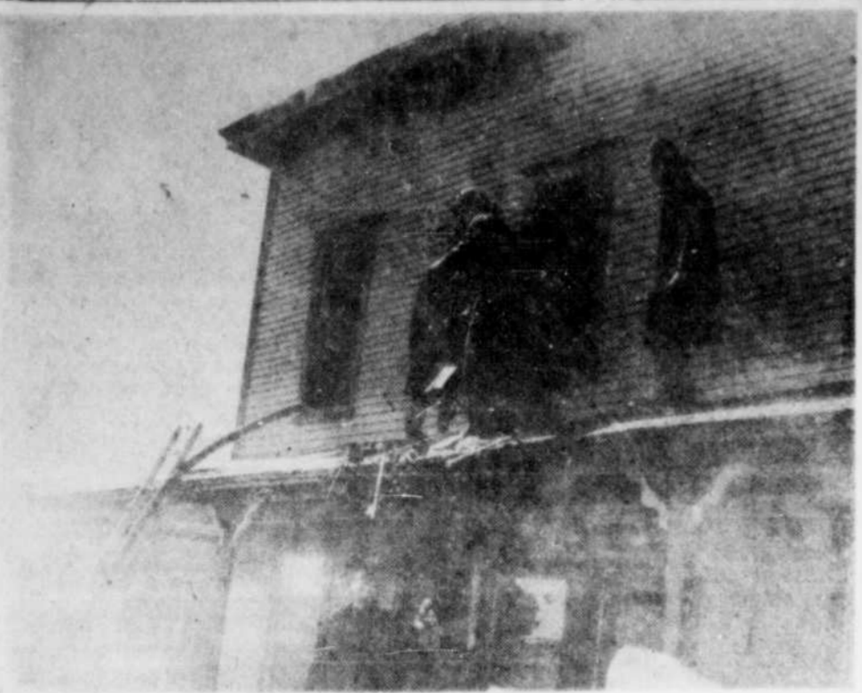
12 PERSONNES SUR LE PAVÉ — Les sapeurs travaillent à éteindre l'incendie qui s'est déclaré au deuxième étage du logement occupé par M. Maurice Collard, au cours de l'après-midi d'hier. Une deuxième famille occupait également cette maison, il s'agit de celle de M. Georges Degre. On sait que douze personnes furent affectées par cet incendie. (Photo La Tribune, par Studio Drummond)
