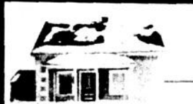
Maison de campagne avec garage. Près du village de Saint-Wenceslas. Sur terrain de 9,500 p.c.
