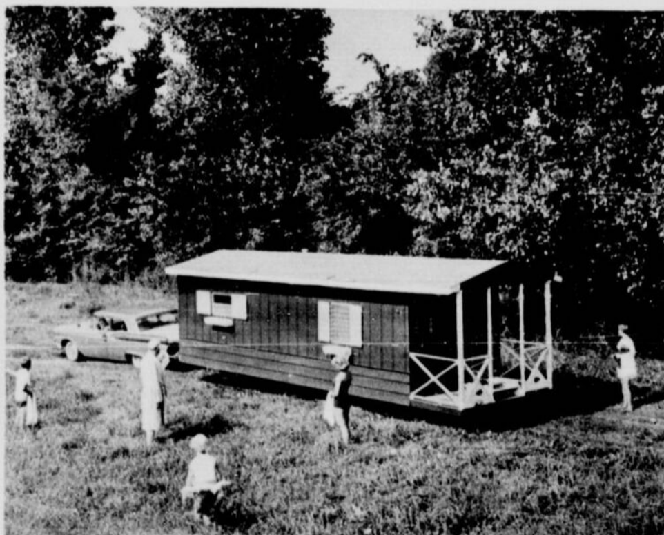
Le saunamobile construit par Cecil Ellis, de Middlefield, Connecticut, et qui est devenu depuis 1950 son gagne-pain. La voiture ne contient aucun métal. Les baigneurs doivent enlever bagues ou médaillons car autrement la température de ces objets leur infligerait des brûlures.
