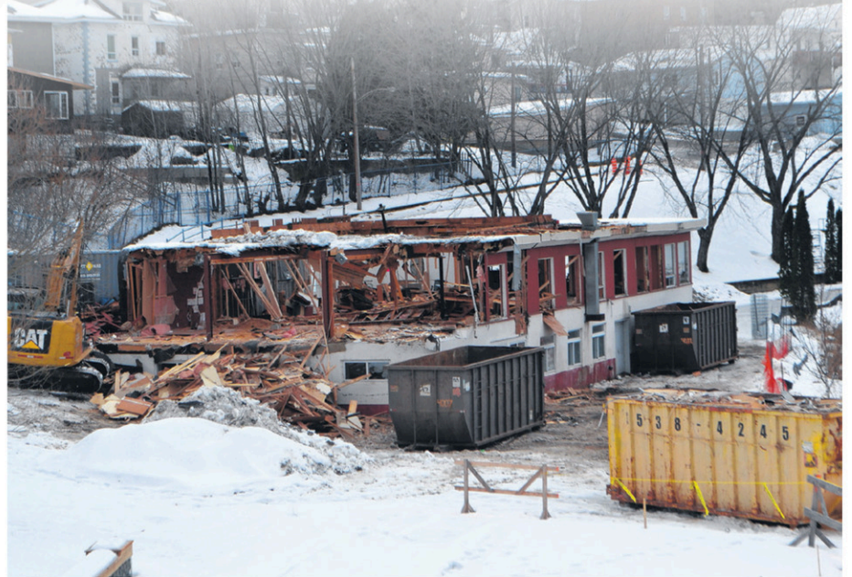
Les travaux ont été entamés en début décembre. (Photo L'Écho de La Tuque - Michel Scarpino)
