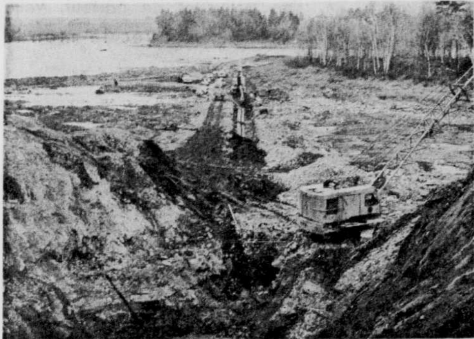
LA PRISE D'EAU — L'eau de la rivière Chaudière est captée par des tuyaux de 16" et 24" de diamètre. On peut voir, au
