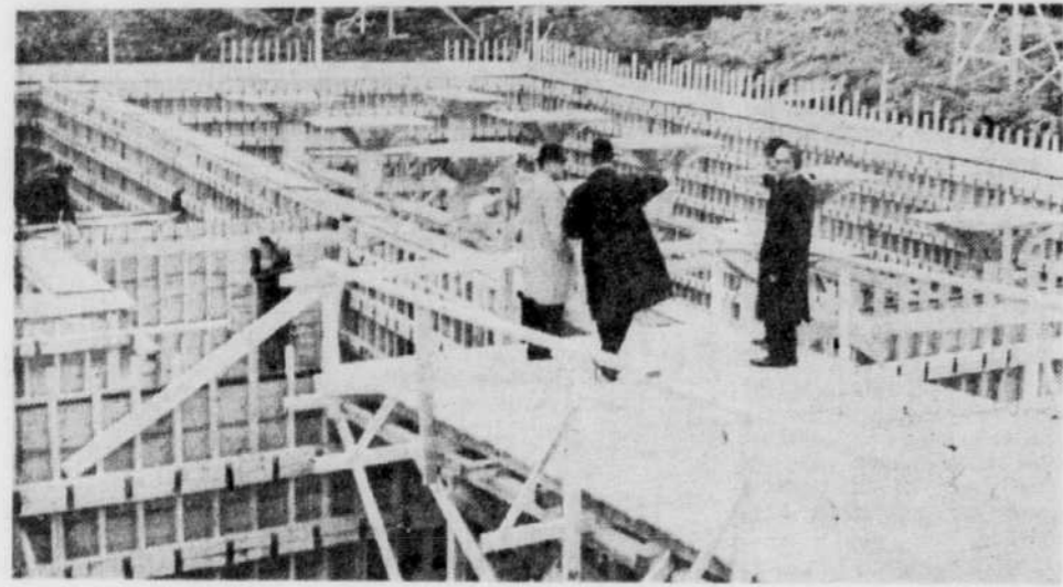
L'USINE DE FILTRATION — D'une capacité initiale de 1.5 million de gallons par jour, l'usine de pompage de Charny actuellement en cours de construction est conçue de telle façon qu'il soit possible, dans l'avenir, d'en augmenter le débit quotidien jusqu'à 6 et même 9 millions de gallons
