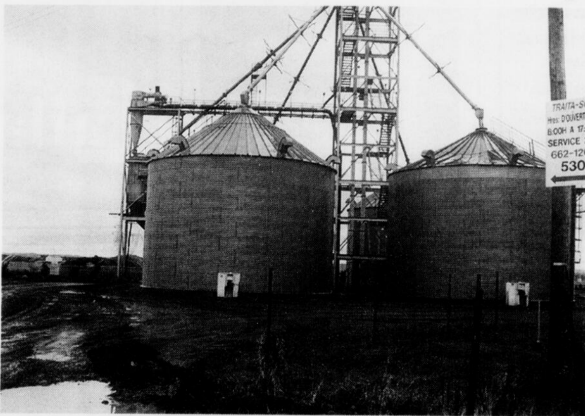
CONTRAT - A lui seul, le contrat du Mont-Apica a nécessité le déplacement de 17 000 tonnes de terre sur le site de Traitement-Sols à St-Bruno.
