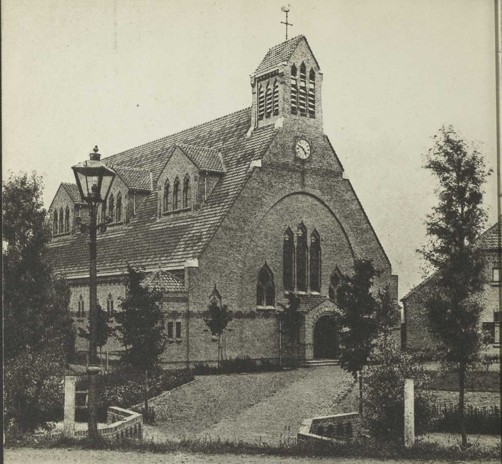
ÉGLISE DE NOORDHOEK (Hollande) Vue extérieure
