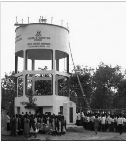
Château d'eau construit par SOPAR-Bala Vikasa dans un village avec le financement de la fondation Roncalli de Montréal
