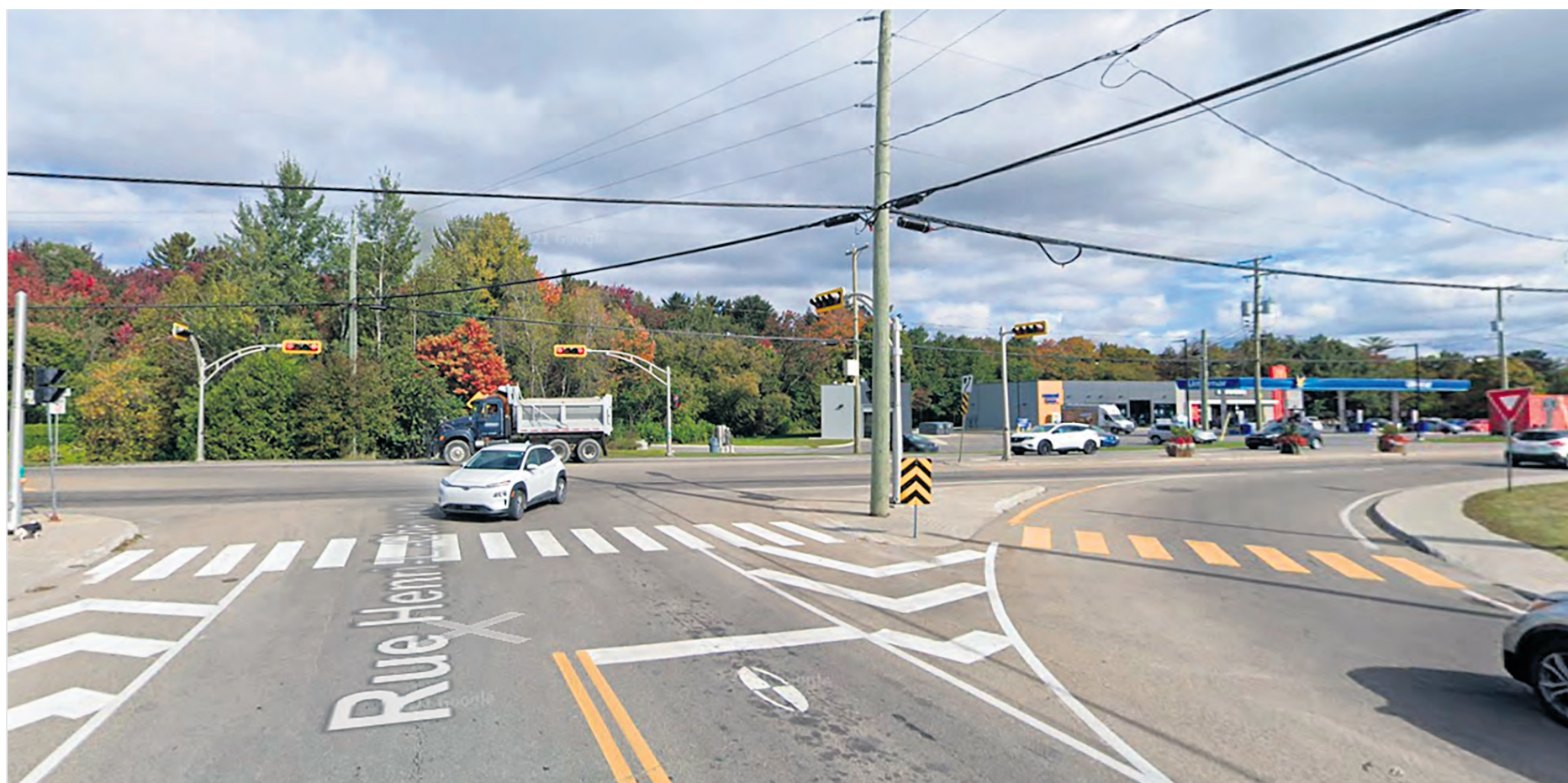
Les futurs travaux relieront la rue Henri-L.-Chevrette à la route 131.
