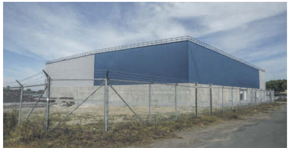
Le nouvel entrepôt de QSL est d'une grandeur de 103 000 pieds carrés et servira à l'implantation d'un futur terminal maritime. Photo Les 2 Rives ©
