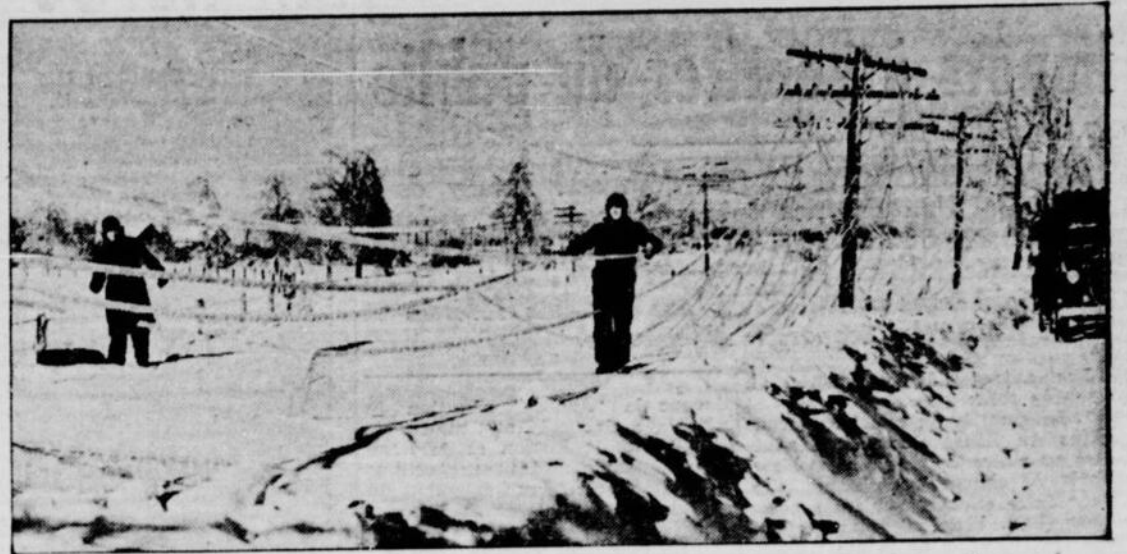
Vue des ravages causés par le verglas sur la ligne téléphonique Montréal-Malone. Cette photo fut prise entre Valleyfield et Ormstown. Les minces fils de cuivre étaient revêtus d'une carapace de glace qui atteignait en certains endroits deux ou trois pouces. Des fils et des câbles pendent sur le sol.
