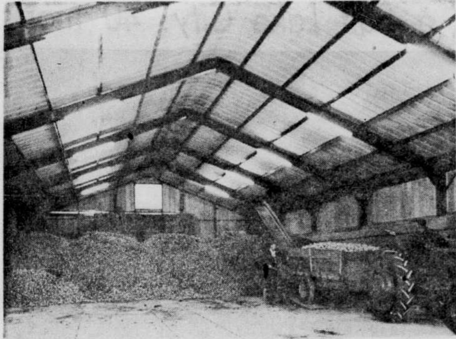
BÂTIMENTS A CHASSIS — Parmi les nouveaux genres de bâtiments de ferme construits aujourd'hui il y a les constructions à chassis telles que celles que montre notre illustration, qui remporte beaucoup de succès. Elles peuvent avoir de nombreux usages, sont très larges, et comportent un
