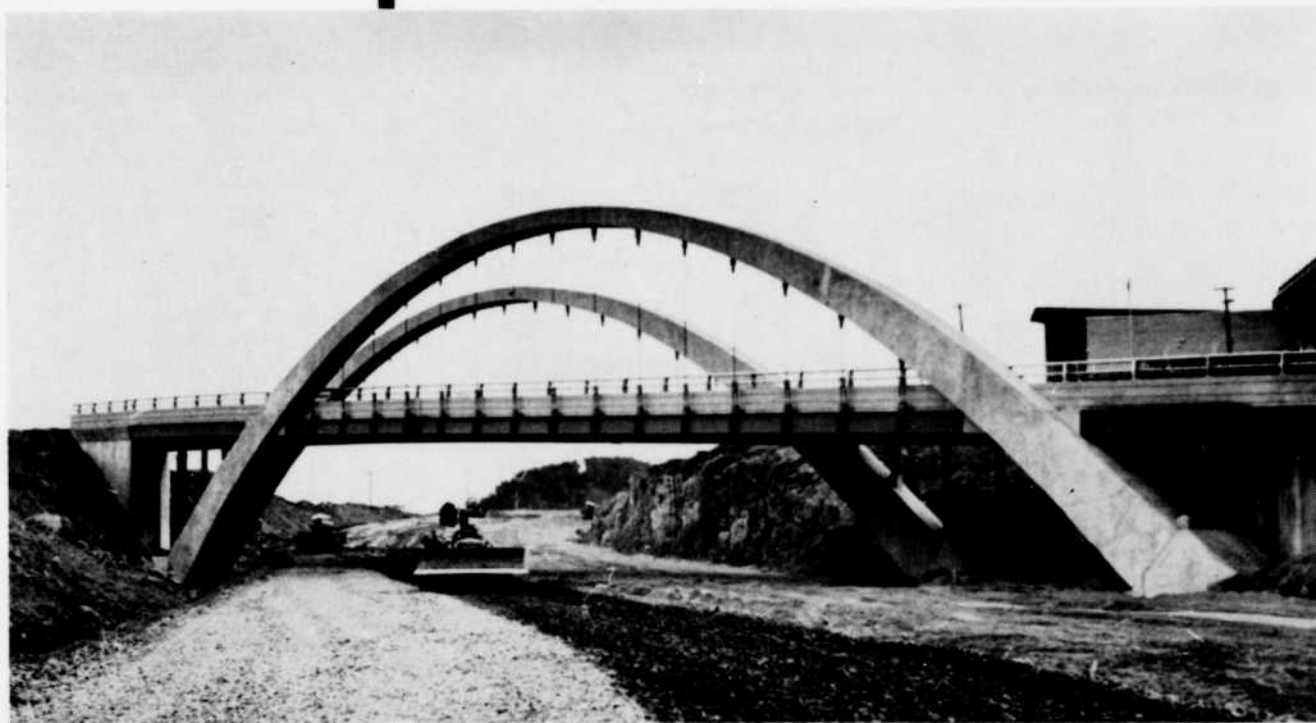
Viaduc au-dessus de l'autoroute des Laurentides près de l'école régionale de Mont-Rolland.
