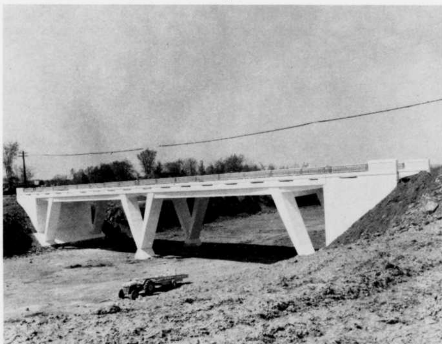
Viaduc de la route no 13, au sud de Granby. L'autoroute des cantons de l'est à cet endroit est complètement en coupe.
