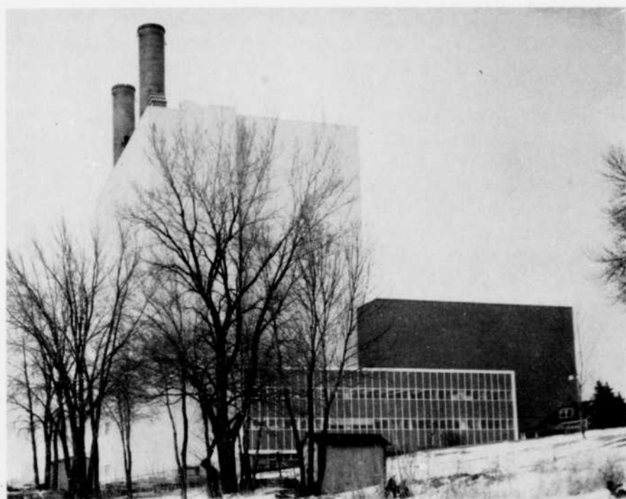
La centrale thermique de Tracy. Hauteur des cheminées : 270 pieds hors sol.
