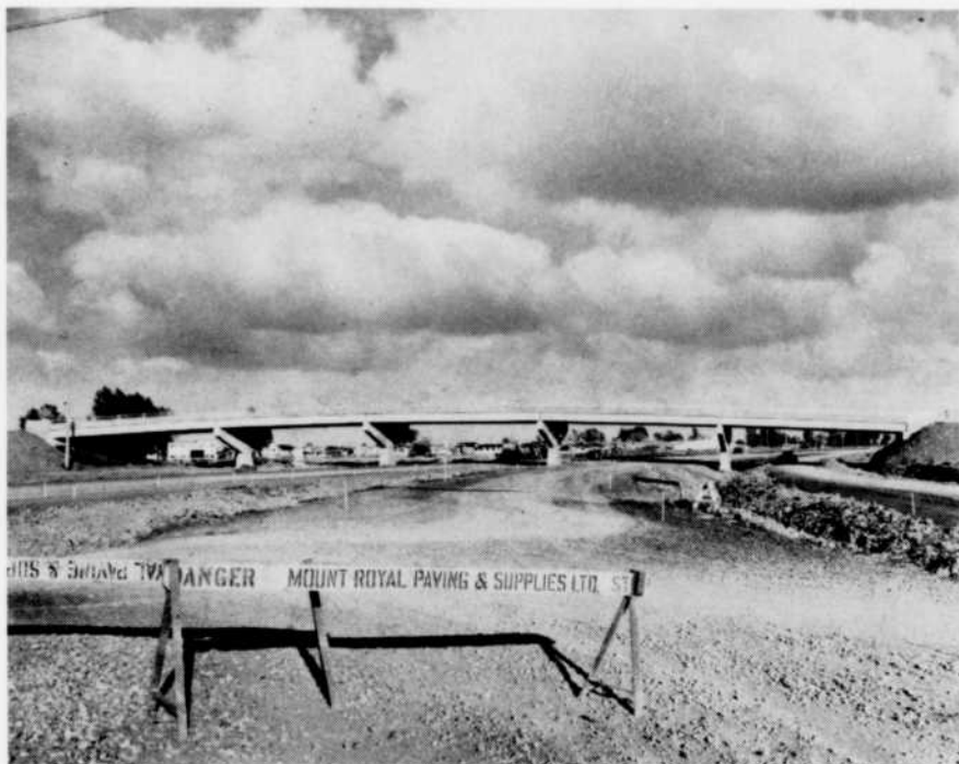
Viaduc du boulevard Milan à Brossard, enjambant l'autoroute des cantons de l'est et les voies locales de chaque côté.
