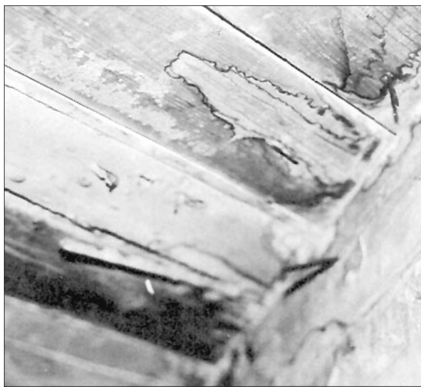
La présence de bois pourri sur les planchers et de taches d'eau au plafond sont des signes évidents d'infiltrations d'eau qui doivent être décelés par un inspecteur compétent.
