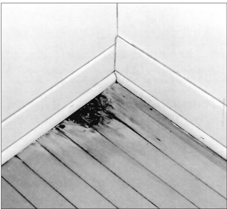
La présence de bois pourri sur les planchers et de taches d'eau au plafond sont des signes évidents d'infiltrations d'eau qui doivent être décelés par un inspecteur compétent.
