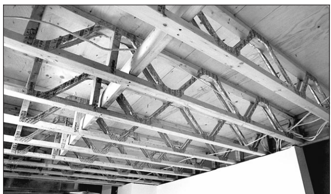
Les poutrelles ajourées favorisent la stabilité des planchers.
