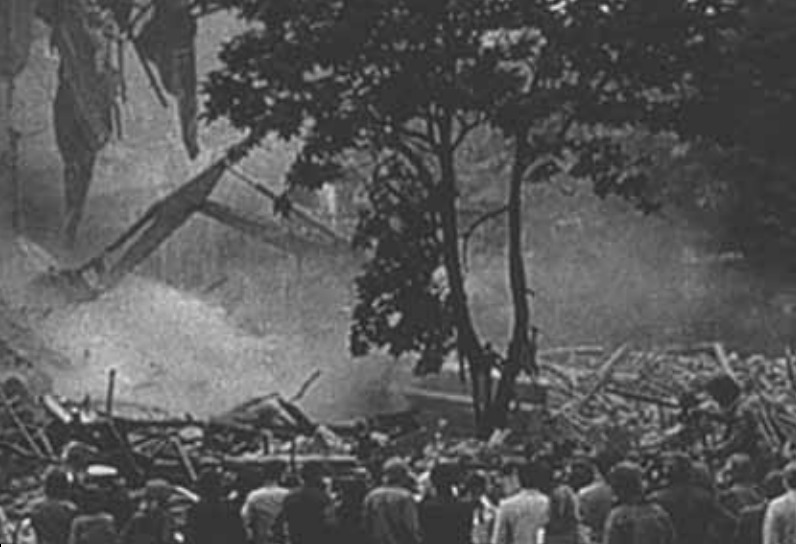
Démolition de la maison Van Horne, 1973 Photo : Archives La Presse
