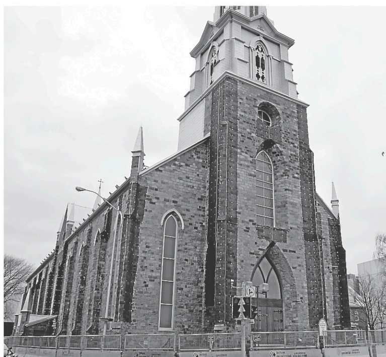
Un important dégât d'eau causé par le bris d'une canalisation des gicleurs est survenu lundi dans la cathédrale de Rimouski, qui éprouve aussi des problèmes avec son système de chauffage. — PHOTOTHÈQUE LE SOLEIL, JOHANNE FOURNIER
