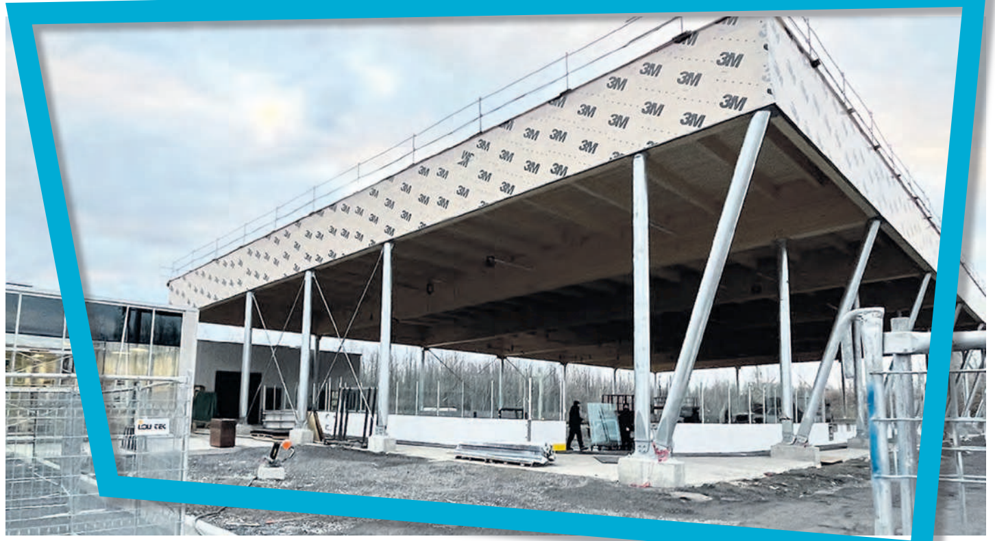
Le chantier est en arrêt pendant les Fêtes. (Photos : Jean-Christophe Noël)
