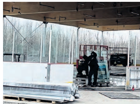
Des ouvriers assemblaient les bandes le 17 décembre dernier.
