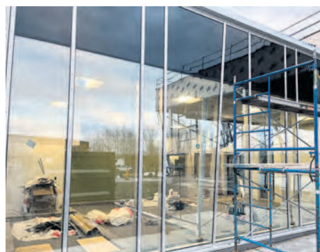
Le chalet d'accueil en construction.
