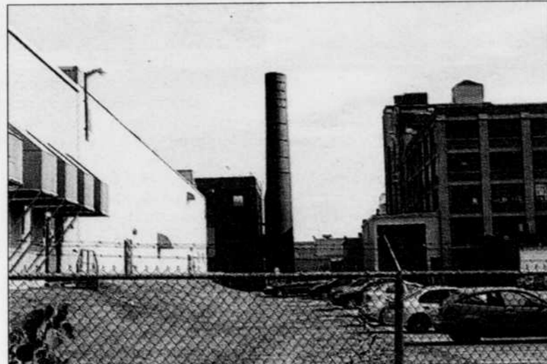
Le drame s'est produit à la centrale thermique. Ce bâtiment est situé entre l'usine Beaulieu Canada et Tarkett, sur le boulevard Magenta, à Farnham.
