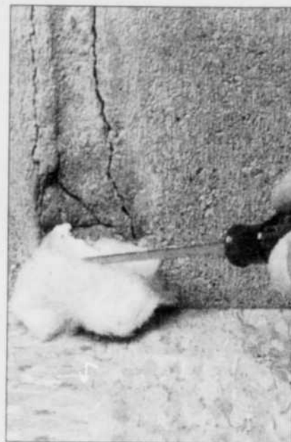
Photo A: Bourrez d'isolant en fibre de verre les trous de plus d'un pouce de profondeur.
