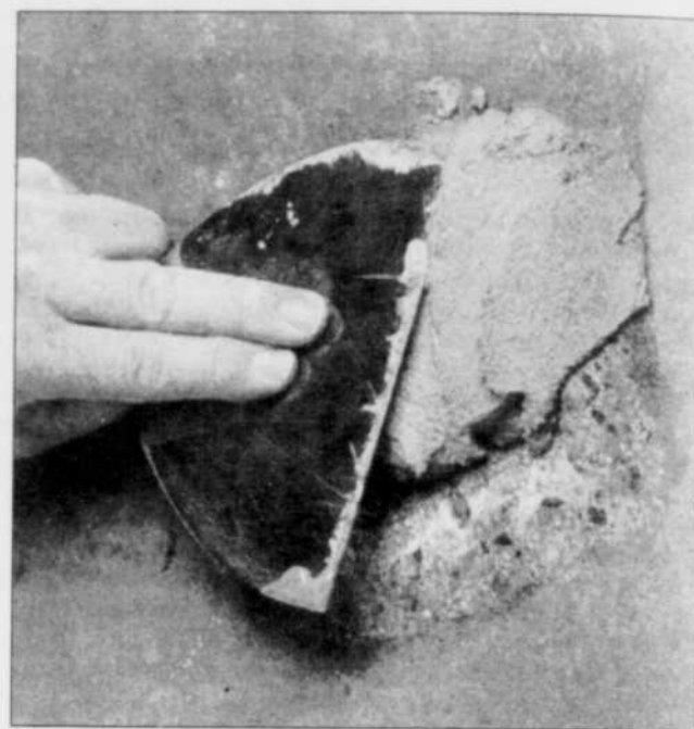
Photo B: Lissez la surface du mélange du ragréage à béton à l'aide d'un couteau flexible.
