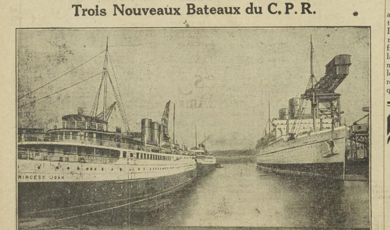
CETTE photographie, prise aux quais des grands chantiers maritimes de la Fairfield Co. à Govan, Ecosse, fait voir trois des derniers bateaux construits pour le compte du Pacifique Canadien par cette compagnie. Ce sont, à gauche, le 'Princess Joan' et le 'Princess Elizabeth', qui seront affectés au service de la côte de la Colombie Britannique, et l'Empress of Japan, puissant océanique de 26,000 tonnes, qui ira augmenter le service trans-pacifique du Pacifique Canadien. On est actuellement à mettre la dernière main à la décoration et à l'aménagement de ces navires qui viendront bientôt en Amérique. L'Empress of Japan sera la première traversée à Québec, où il est attendu le 20 juin prochain. Un autre grand paquebot de 40,000 tonnes, l'Empress of Britain, est aussi en construction pour le Pacifique Canadien en ce moment.
