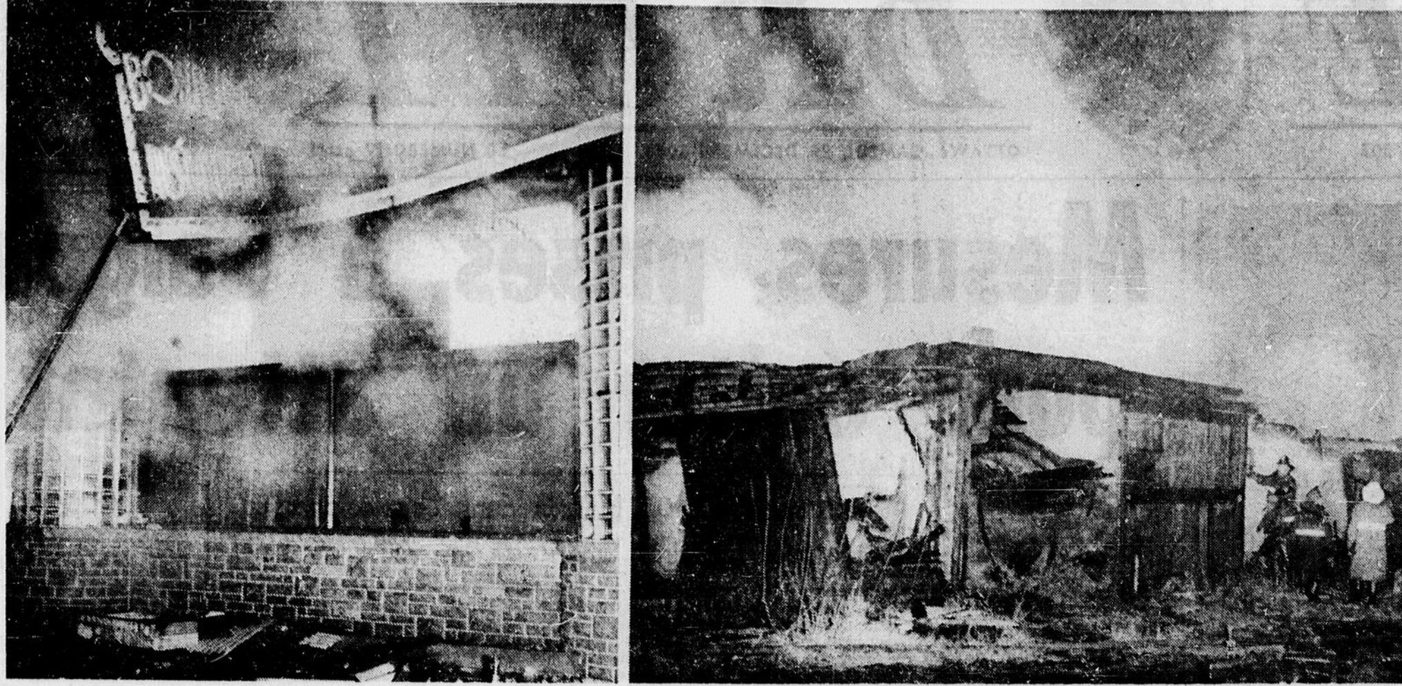
Au plus fort de l'incendie, le restaurant Oasis ainsi que l'entrepôt où débuta l'incendie... final.
