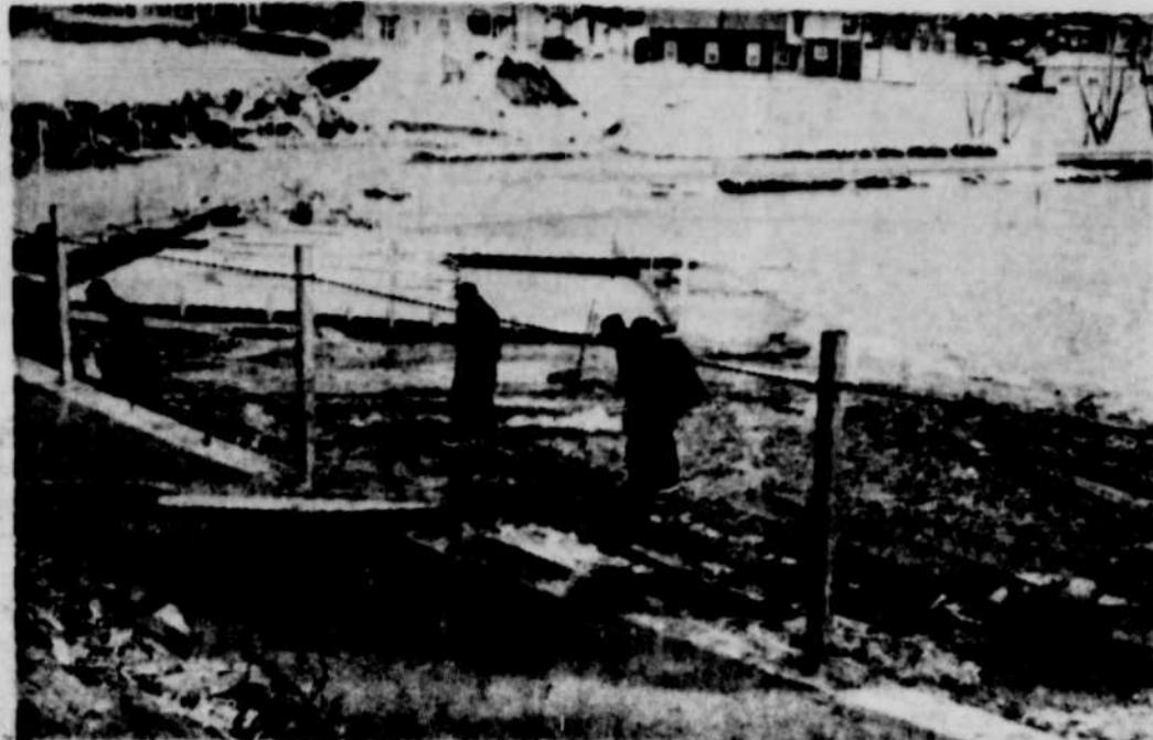
LES EMPLOYÉS municipaux de La Tuque s'affairent depuis quelques jours à la construction d'un lot flottant en forme d'étoile qui sera des fois orné de fleurs et d'arbustes au milieu du petit lac. Nous voyons au premier plan une partie du rempart de ciment qui a été érigé au cours de l'hiver.
