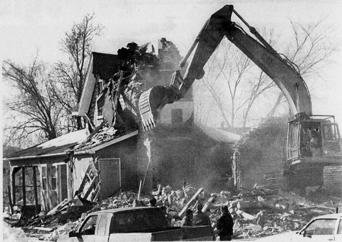
La maison Hammond subit l'événement coriace d'une pelle mécanique qui a tôt fait d'abattre les murs — et tout le reste — de la demeure centenaire.
