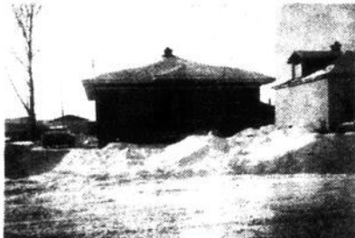
11 RUE MICHAUD, VICTORIAVILLE Maison 36 x 27. Terrain 50 x 152. Finition brique.
