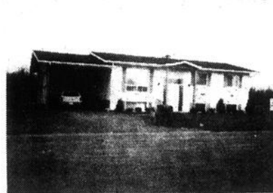
75 AVE DES BOULEAUX Maison 40 x 26, carport 14 x 26. Chauffage eau chaude. Sous-sol fini. Construite en 1971.
