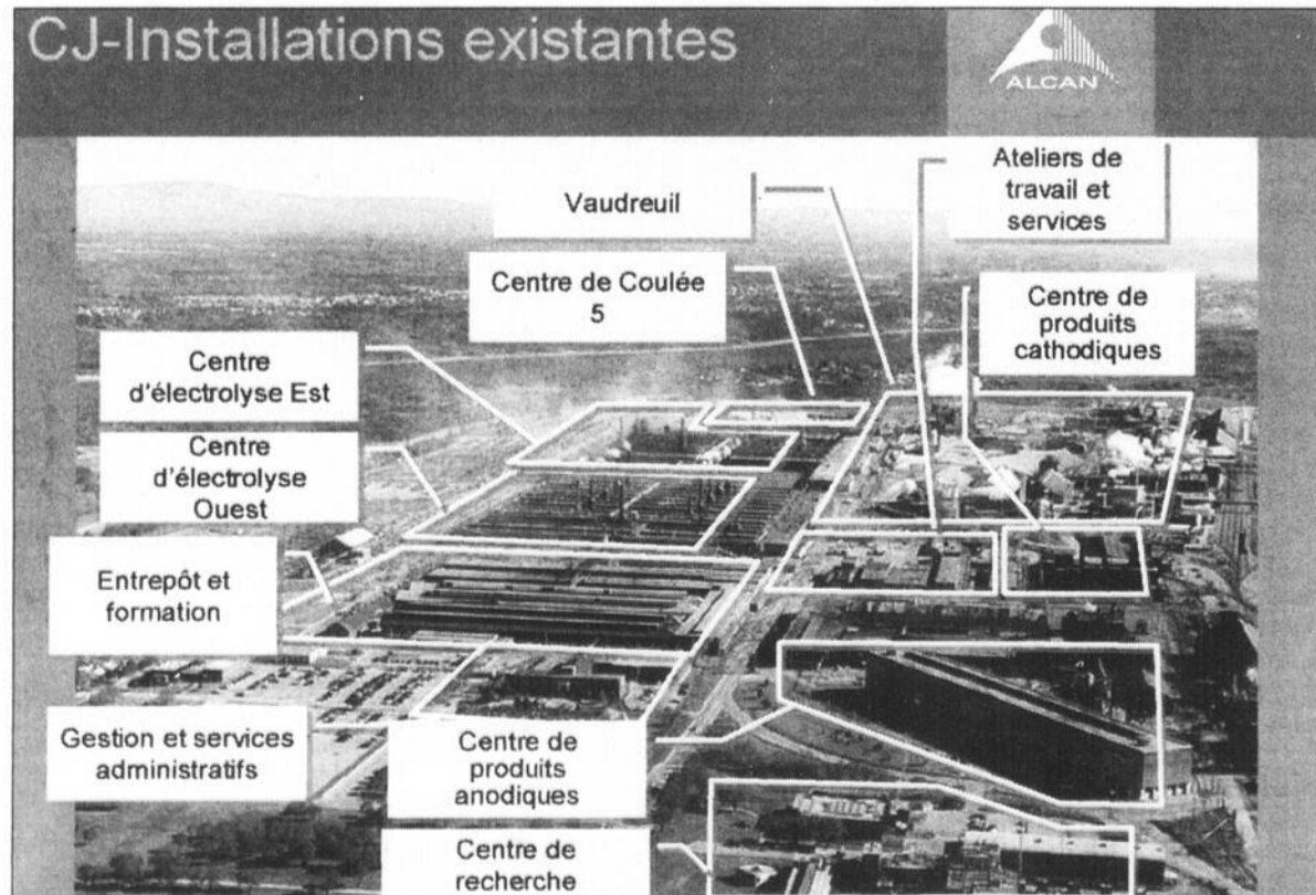
INSTALLATIONS - Les 10 centres d'affaires du Complexe Jonquière ont été présentés avec leur nombre d'employés et leur appréciation de bon à dangereux. L'usine chimique Vaudreuil, le centre des cathodes et les salles de cuves pré-cuites sont tous dans le rouge, mais la situation ne serait pas dramatique.
