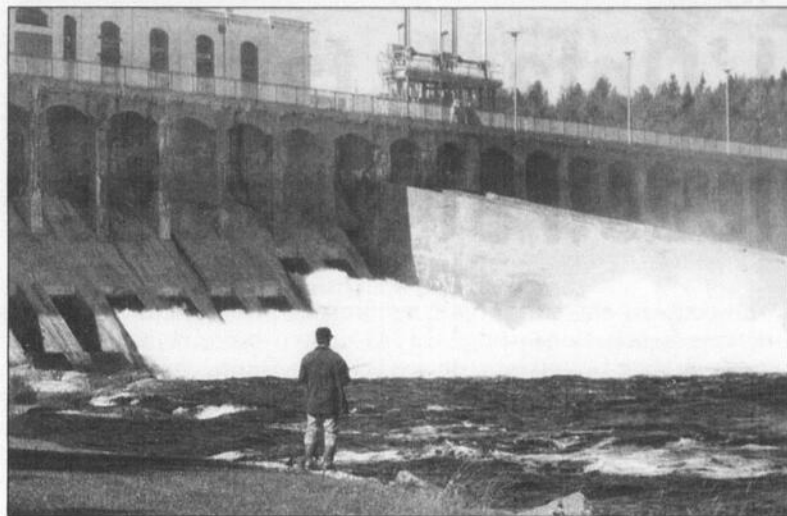
DÉBIT - Au cours de la nuit de jeudi à vendredi, le débit d'évacuation de Pibrac et Portage-des-roches (photo) a été porté à 280 mètres cube à la seconde, puis à 360 m.c./sec. durant la journée.
