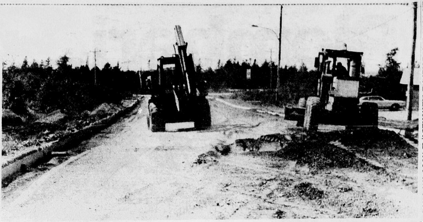
On va enfin paver les rues du parc industriel de Matane. Personne ne trouvera à redire là-dessus. Des travaux considérables sont en cours.
