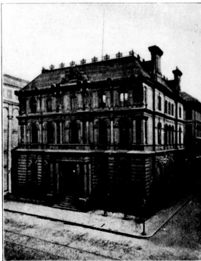
EDIFICE DE LA BANQUE MOLSON.
