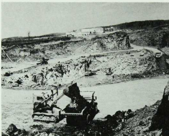
Mine à ciel ouvert dont les gisements de columbium, à Oka, sont exploités par St. Lawrence Columbium and Metals Corporation.
