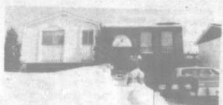
MASCOUCHE: sous-sol fini, garage, C. VAILLAN- COURT 471-4001
