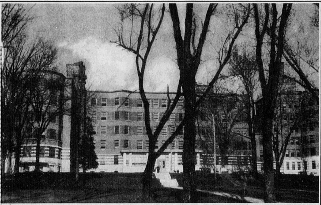
Vue de l'hôpital Hôtel-Dieu, en 1946, et du Sanatorium Saint-François à droite.
