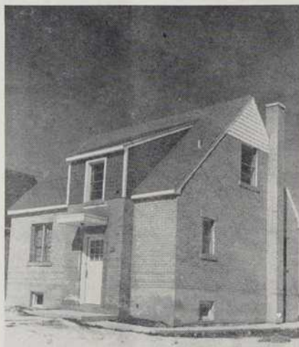
Types de maisons en construction à St-Laurent.
