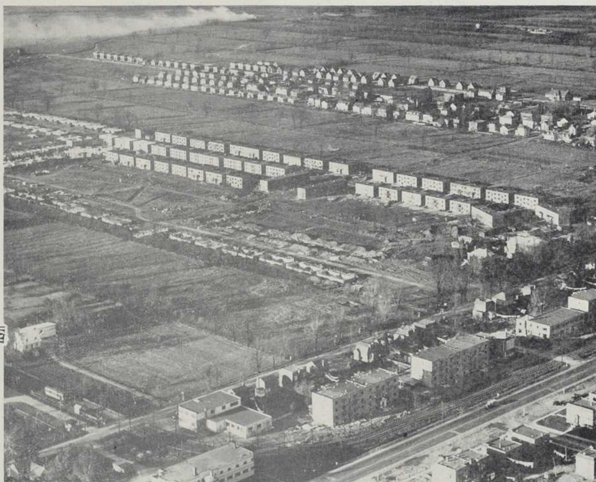
Vue des travaux de construction exécutés pour la Société Centrale d'Hypothèques et de Logement, centre d'Habitations, projet no. 1 - 48, Ville St-Laurent, par
