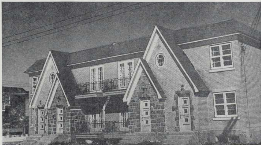
Duplex construit à Ville Saint-Laurent.
