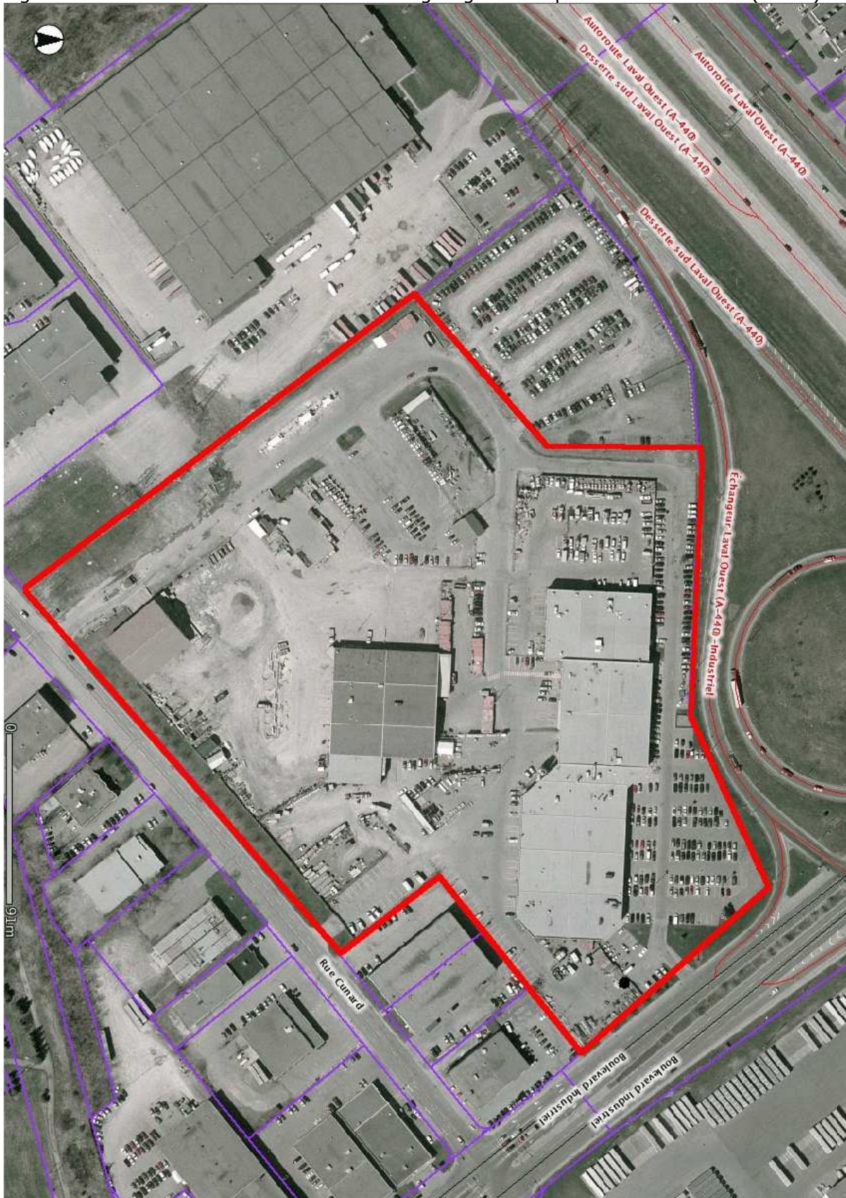
Photo : Ville de Laval (Hauts-Monts INC., avril 2007).
