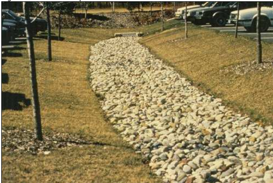
Figure 13. Autre exemple de bassin de rétention sur un terrain de stationnement
