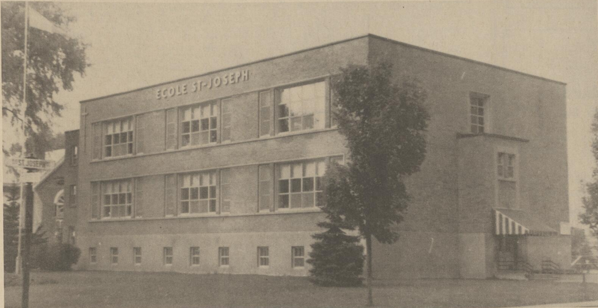
L'école Saint-Joseph où les religieuses enseignent aux fillettes du cours élémentaire depuis 1949. L'édifice a été construit sur le site même de la première église de Bedford incendiée en 1909.
