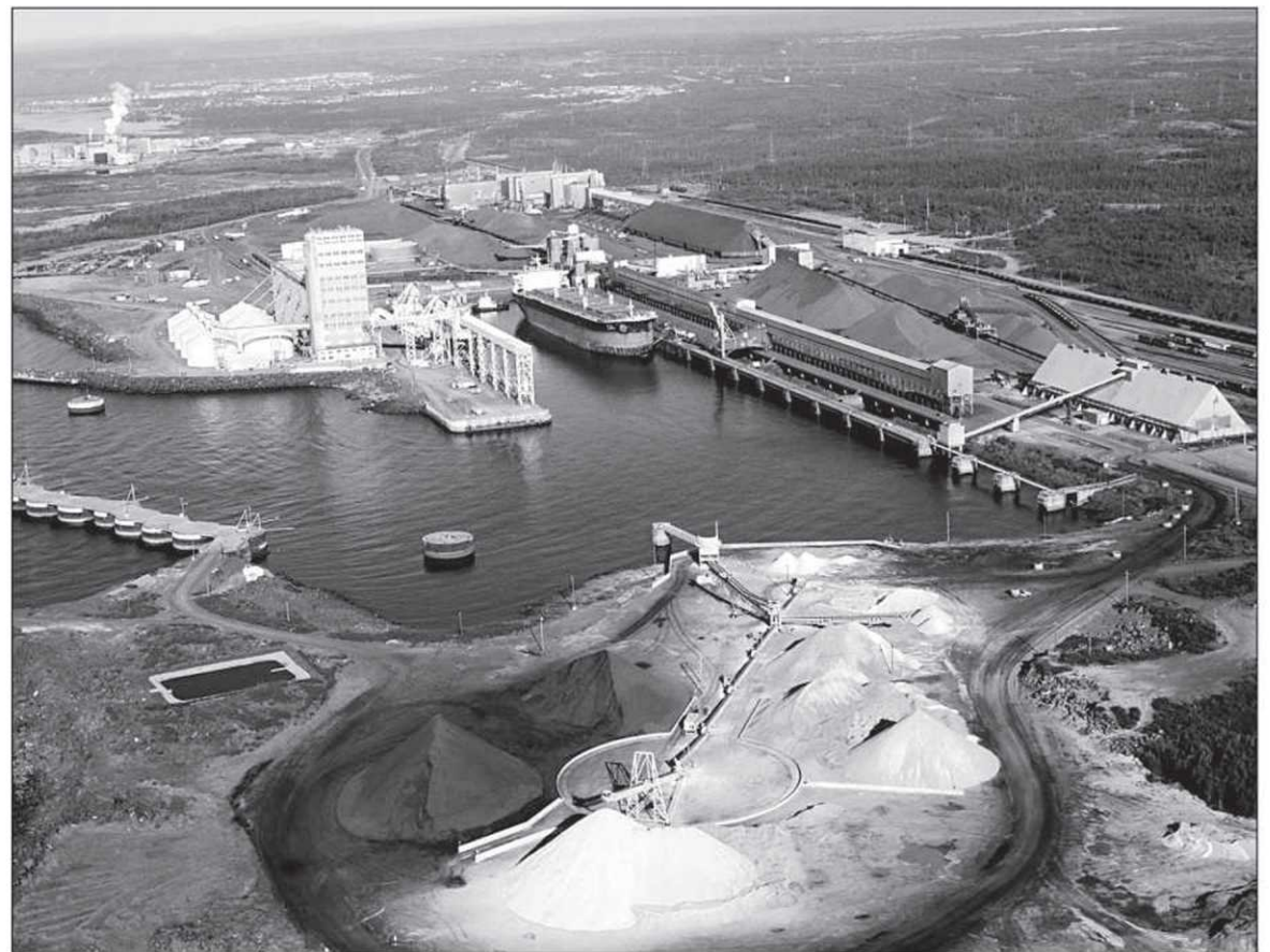
Vue d'ensemble des installations de Québec Cartier, à Port-Cartier. — PHOTO COURTOISIE QUÉBEC CARTIER
