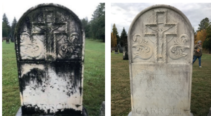
La pierre tombale de John Patrick Carroll, avant et après le nettoyage. Source : Réseau canadien pour la préservation de la migration irlandaise
