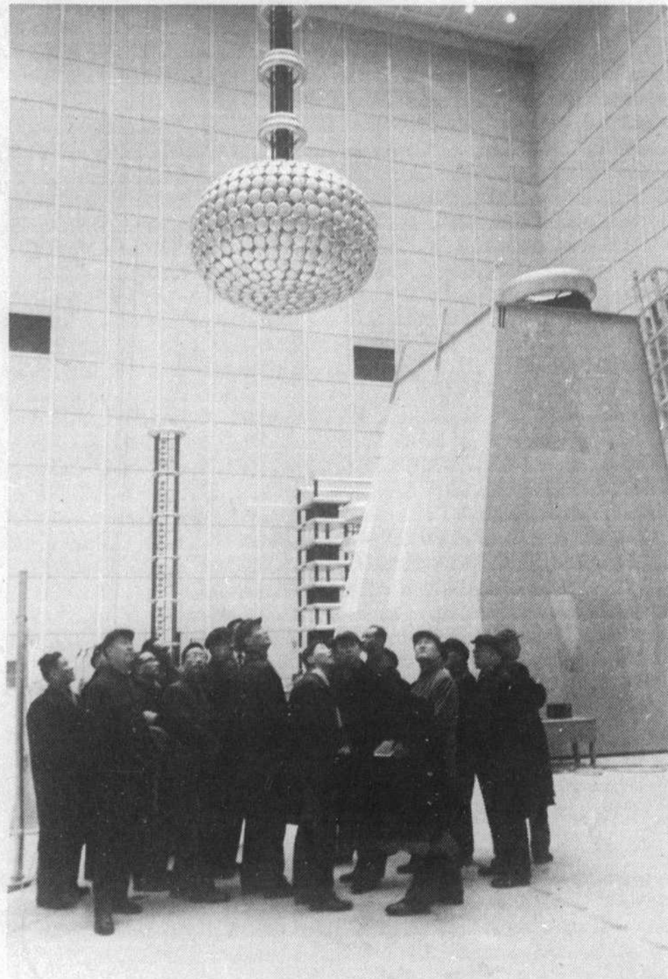
L'Hydro-Québec a reçu une mission de 20 ingénieurs de la Chine populaire qui séjournent au Canada en vue de se familiariser avec les techniques et les méthodes canadiennes de production et de transport de l'énergie électrique. La délégation a visité à Laval l'un des deux postes majeurs de transformation de la région de Montréal, le poste Duvernay, qui est alimenté par l'énergie à 735,000 volts produite par Churchill Falls et par les centrales du complexe Manic-Outardes. Les membres de la mission se sont ensuite rendus à l'institut de recherche de l'Hydro-Québec, à Varennes, où ils ont visité les laboratoires généraux et le laboratoire haute tension (notre photo) en plus de s'entretenir avec les chercheurs de l'institut. Le ministre canadien de l'industrie et du commerce a organisé le séjour de deux semaines des ingénieurs chinois qui doivent également visiter certaines des installations de l'Ontario Hydro et de l'Énergie atomique du Canada.
