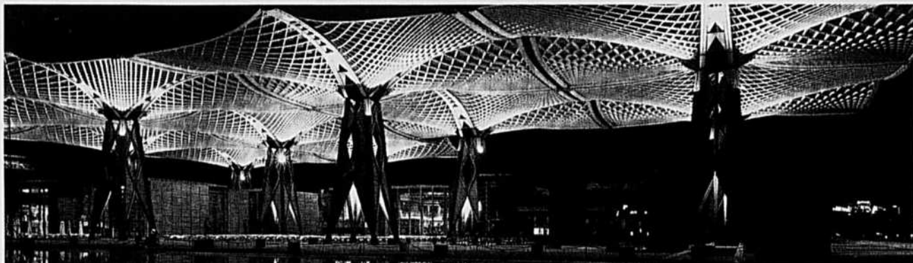
Une toiture, fabriquée en bois lamellé, couvre le pavillon principal du site de l'exposition de Hanovre en Allemagne.
