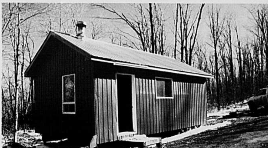
Un des trois chalets de chasse aménagés pour cinq ou six chasseurs.
